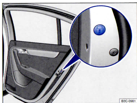
Илл. 212 На торце задней правой двери: прикрытый резиновой заглушкой аварийный замок.
