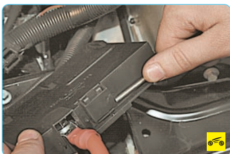
4. Отожмите отверткой фиксатор и снимите крышку блока предохранителей.
