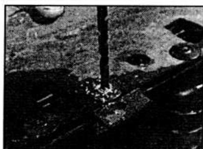
Рис. 3.27. Высверливание заклепок крепления брызговика к радиатору.
